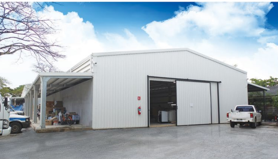
Thanawut Warehouse - Nakhon Si Thammarat
