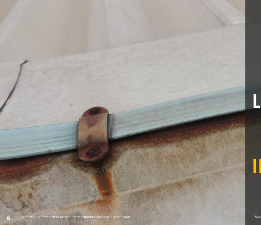
**EVEN IF** CLADDING **CAN LAST** LONG, FAILURE COULD BE **DUE TO** INCOMPATIBLE MATERIAL
