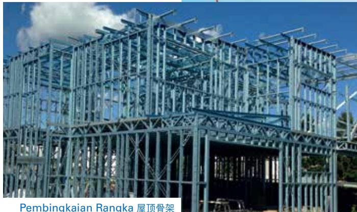
Pembingkaian Rangka 屋顶骨架
