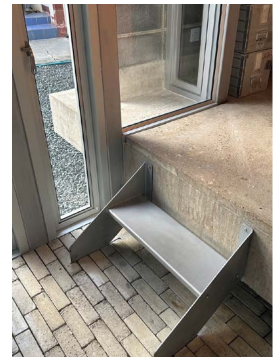
รายละเอียดการเลือกใช้วัสดุเหล็กมาดัดแปลงเป็น ส่วนประกอบโครงสร้างต่างๆ ภายในอาคาร อาทิ เหล็กเป็นผนังกัน หรือบันไดเหล็กที่สั่งพับขึ้นรูปให้ดูโปร่งและบางเบา
