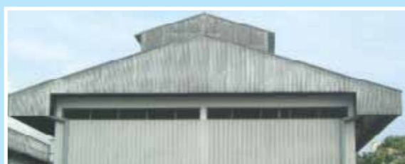
Bụi bám trên bề mặt thép mạ màu thông thường không thể rửa trôi
